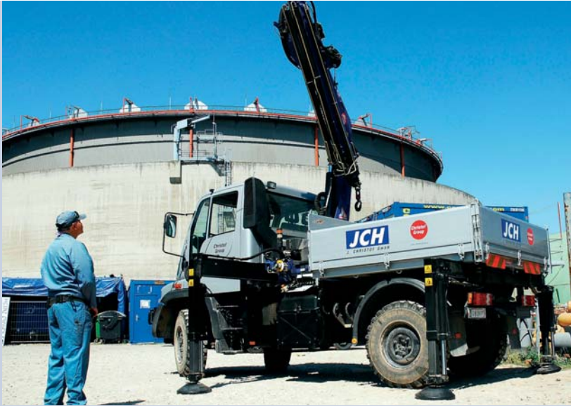
Ein vielseitiger „Bauarbeiter“.
