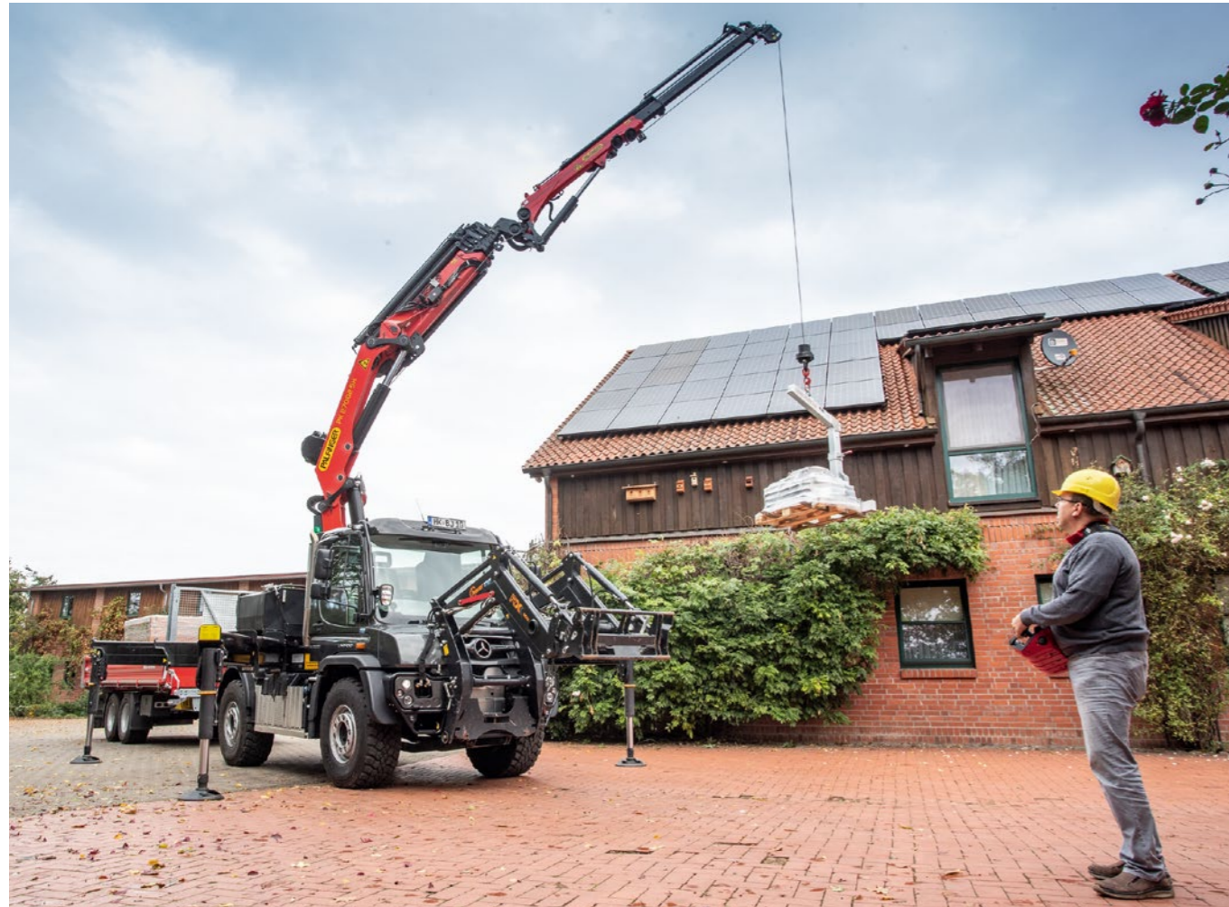
Hoch hinaus: Mit seinem Ladekran erreicht Bernd Jastremski jede Dachbaustelle.
